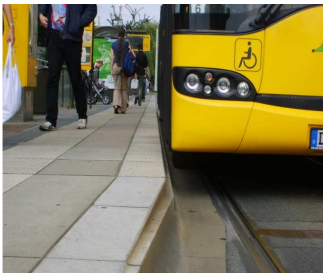
Rys. 9.8.2.1. Zalecane ukształtowanie krawędzi peronowej. Źródło: opracowanie własne.
