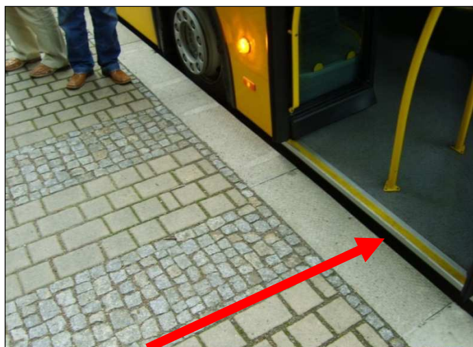
Rys. 9.8.2.2. Strefa wejściowa – inny rodzaj nawierzchni naprzeciwko pierwszych drzwi autobusu. Źródło: opracowanie własne.
