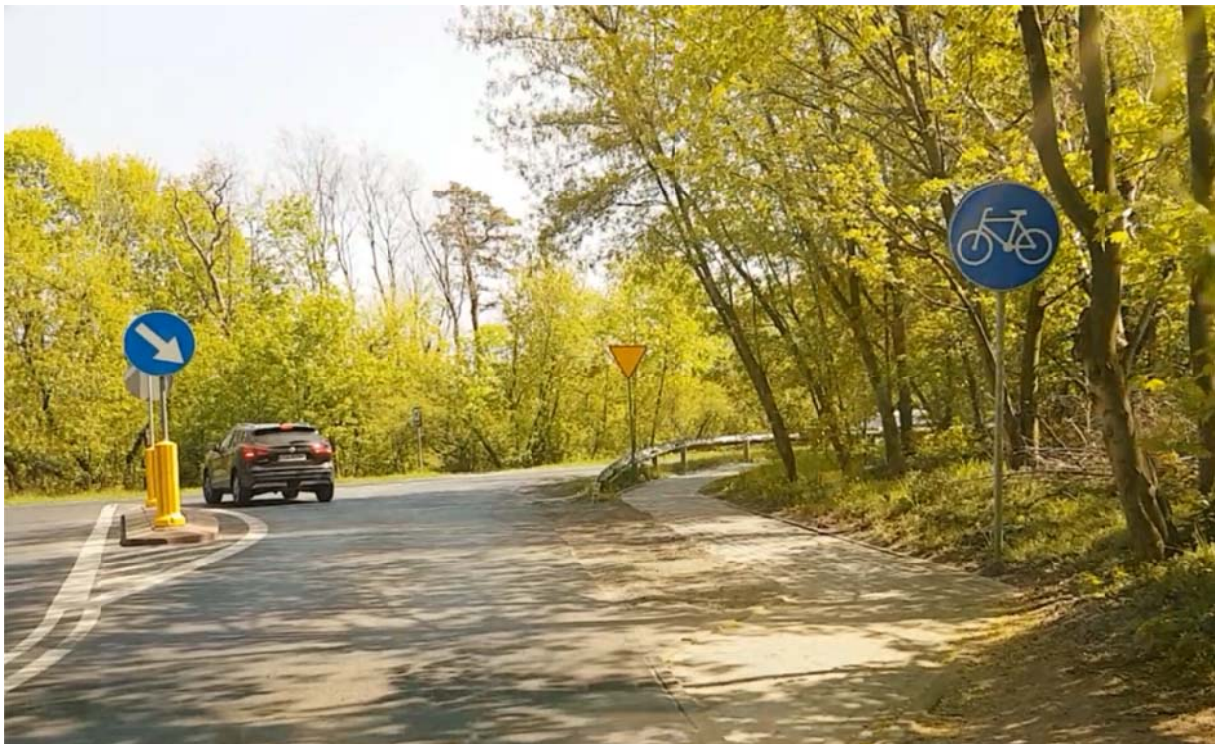
Rys. 3.16 Trasa nr 13 – wjazd w ul. Kostrzewskiego od strony ul. Prostej – stan istniejący
