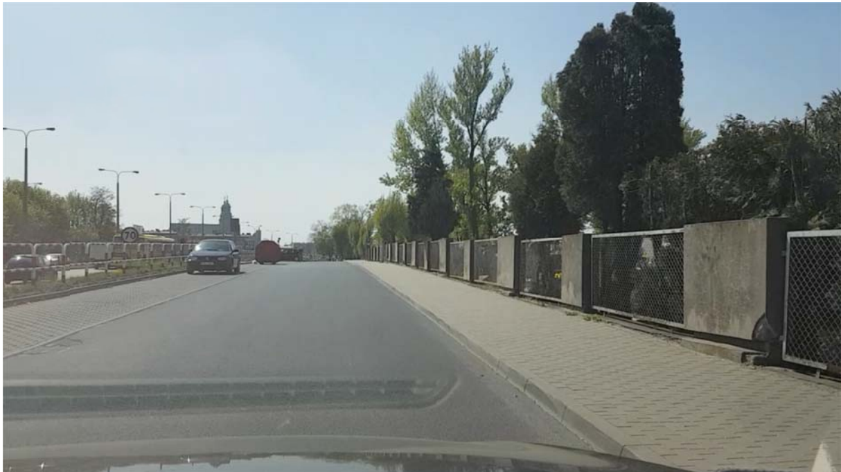
Rys. 4.61 ul. Żuławy – stan istniejący
