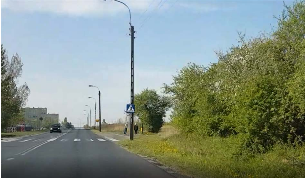
Rys. 4.1 ul. Gdańska – stan istniejący
