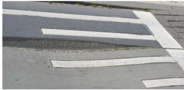
Rys. 2.29 Przykład zastosowania progów zwalniających bez ograniczeń dla rowerzystów
