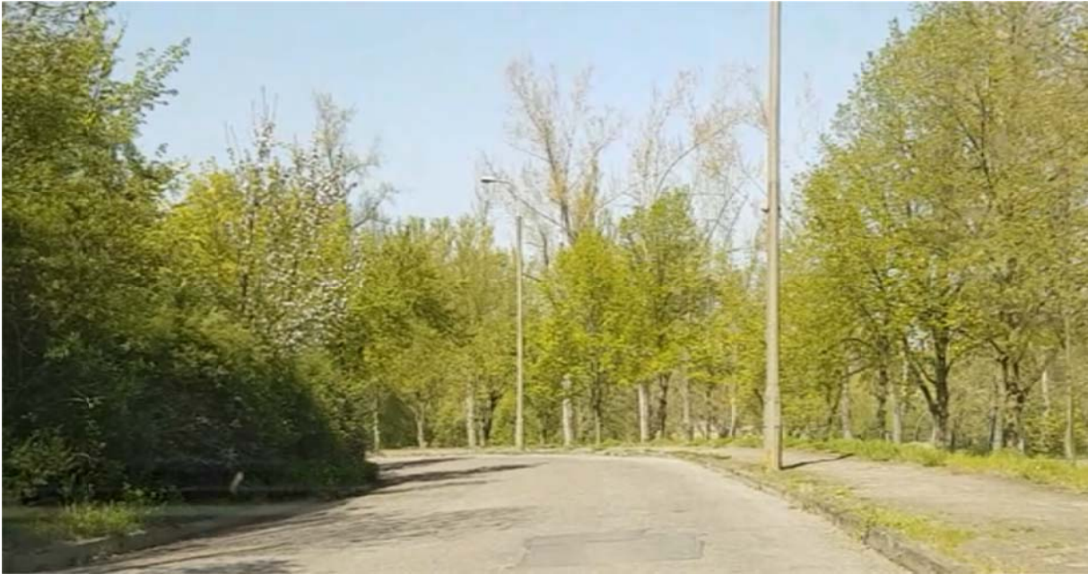
Rys. 4.16 ul. Strumykowa – stan istniejący
