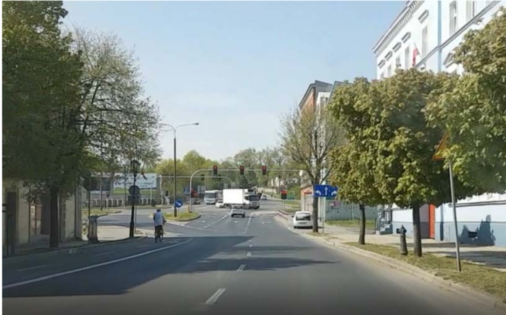
Rys. 3.7 Trasa nr 6 – ul. Łaskiego – stan istniejący
