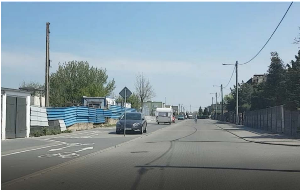
Rys. 3.4 Trasa nr 3 – ul. Roosevelta przy skrzyżowaniu z ul. Reja – stan istniejący
