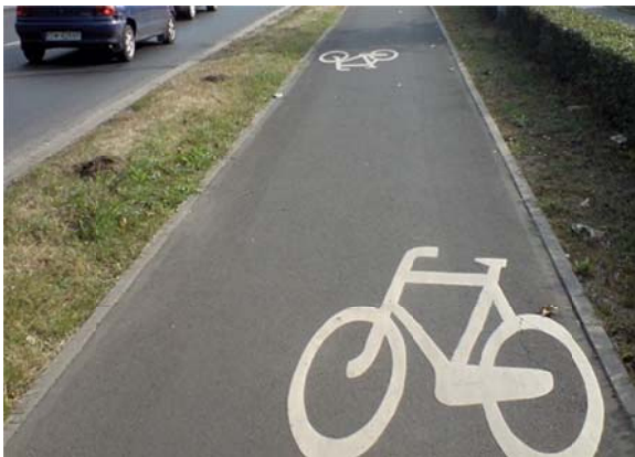
Rys. 2.15 Przykład drogi rowerowej odseparowanej zielenią od ruchu samochodów oraz pieszych [19, 6]
