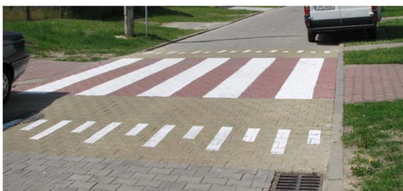
Rys. 2.32 Przykład zastosowania wyniesionej powierzchni przejścia dla pieszych
