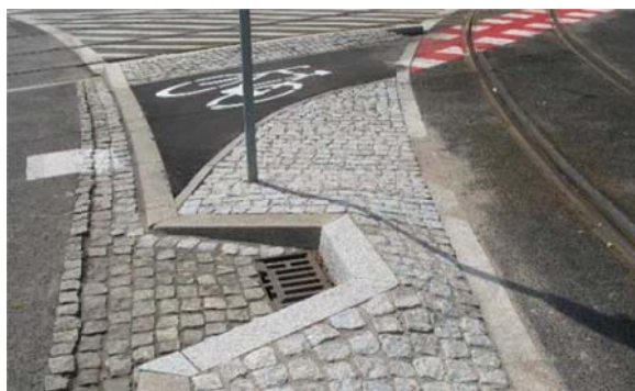
Rys. 2.41 Sposób zagospodarowanie jezdni w przypadku występowania studzienek [3]
