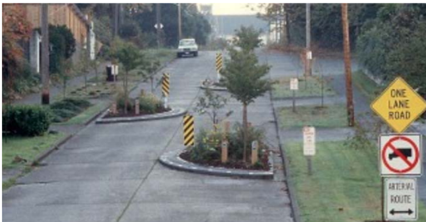
Rys. 2.31 Przykład zastosowania wysp wypełnionych zielenią wysoką [24]
