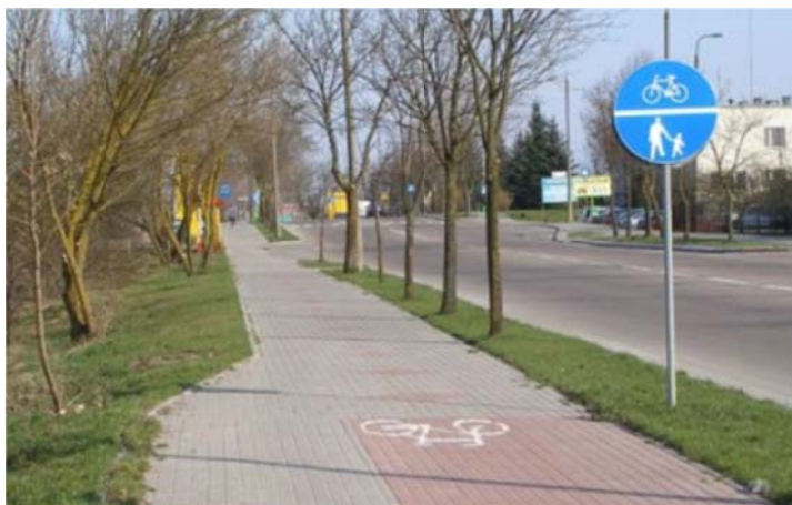
Rys. 2.21 Przykładowa lokalizacja istniejącego ciągu pieszo-rowerowego z błędnym oznakowaniem [20]
