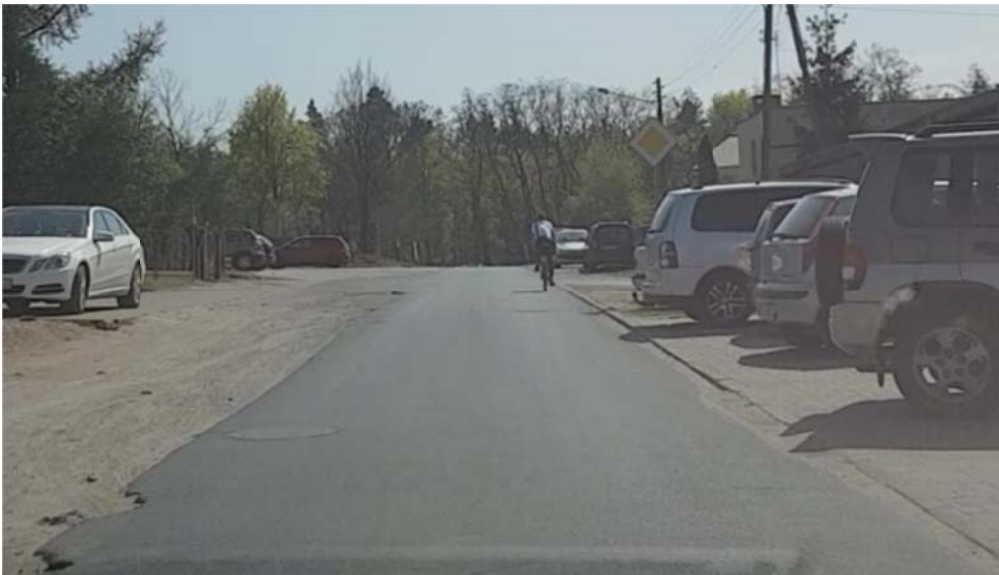
Rys. 4.40 ul. Cechowa – stan istniejący
