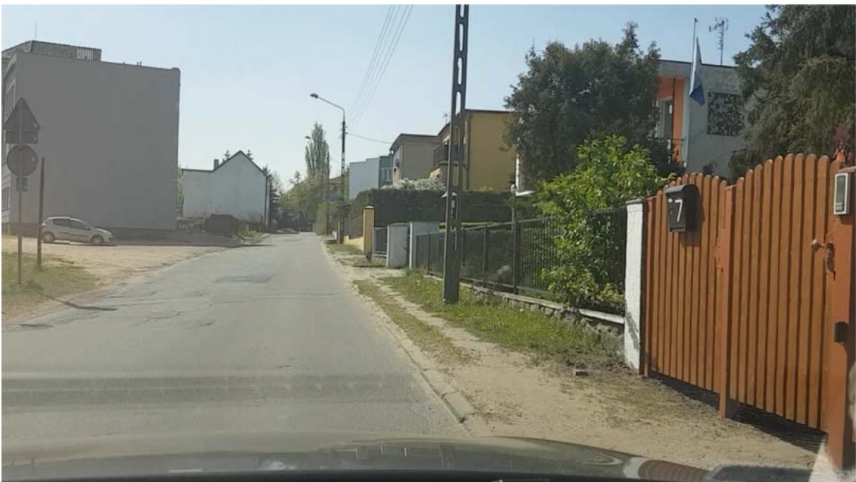
Rys. 4.59 ul. Żabia – stan istniejący
