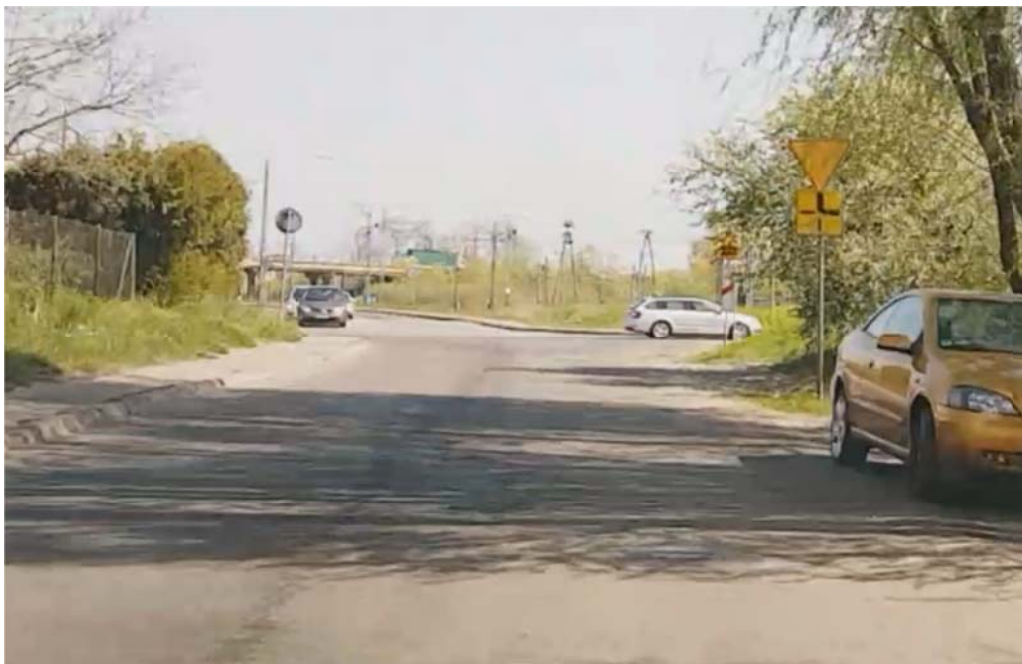
Rys. 4.45 ul. Rzepichy – stan istniejący
