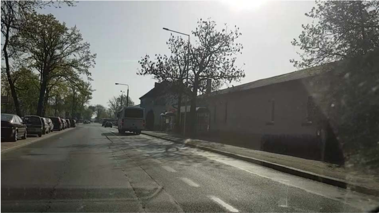
Rys. 4.9 ul. Dworcowa – stan istniejący
