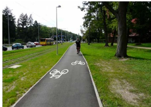
Rys. 2.15 Przykład drogi rowerowej odseparowanej zielenią od ruchu samochodów oraz pieszych [19, 6]
