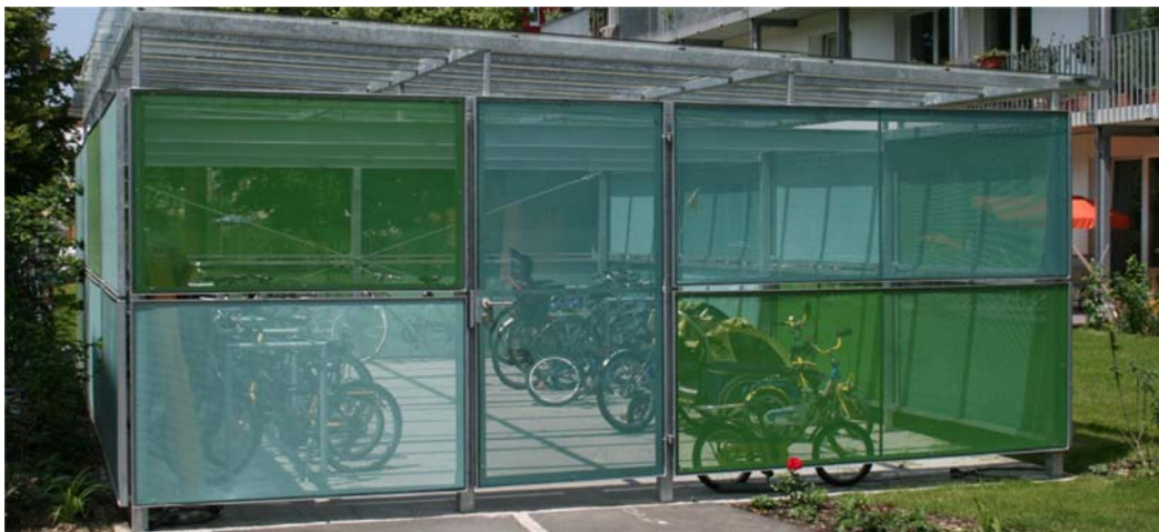
Rys. 2.39 Kryty parking rowerowy, ogrodzony na osiedlu mieszkalnym [10]
