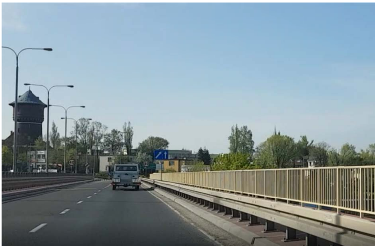
Rys. 4.4 – Wiadukt Solidarności - stan istniejący
