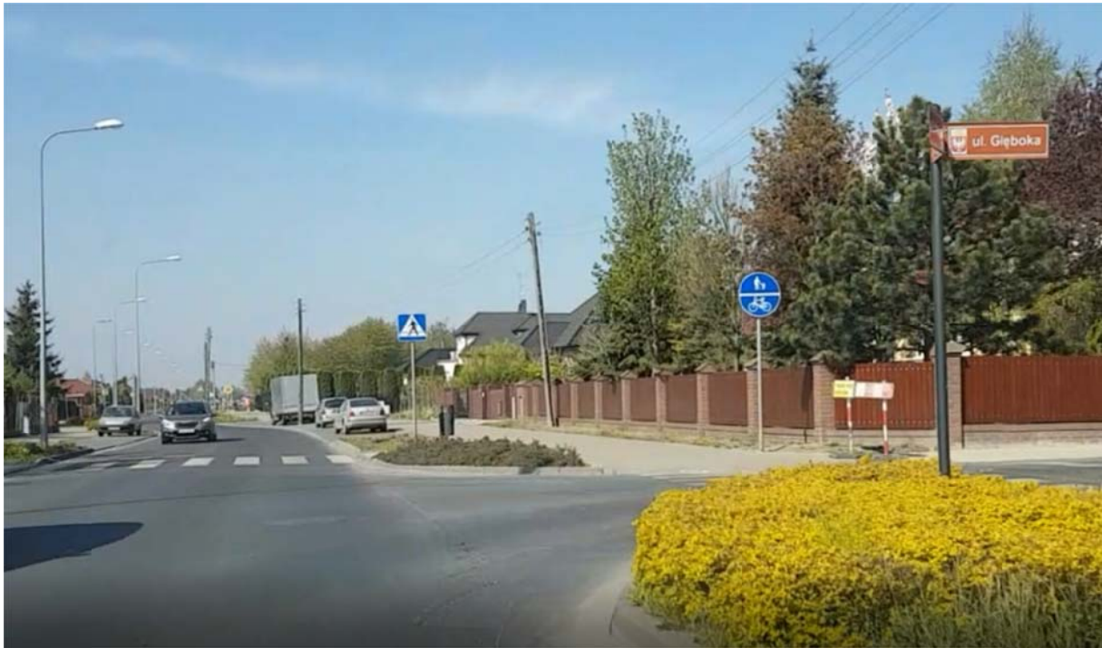
Rys. 3.10 Trasa nr 9 – ul. Orzeszkowej przy skrzyżowaniu z ul. Głęboką – stan istniejący
