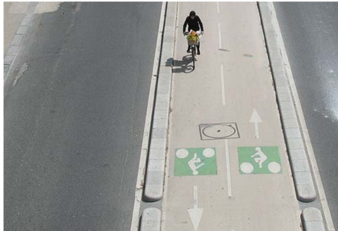
Rys. 2.35 Przykład zastosowania betonowych separatorów prefabrykowanych
