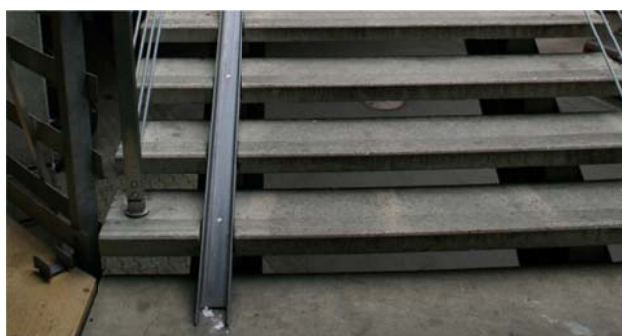
Rys. 2.42 Przykład zastosowania rampy rowerowej na schodach [10]
