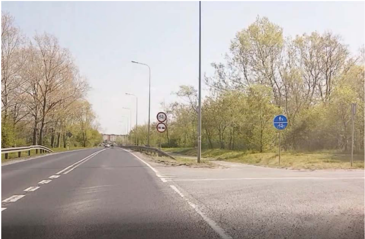
Rys. 3.15 Trasa nr 13 – ul. Kostrzewskiego – stan istniejący
