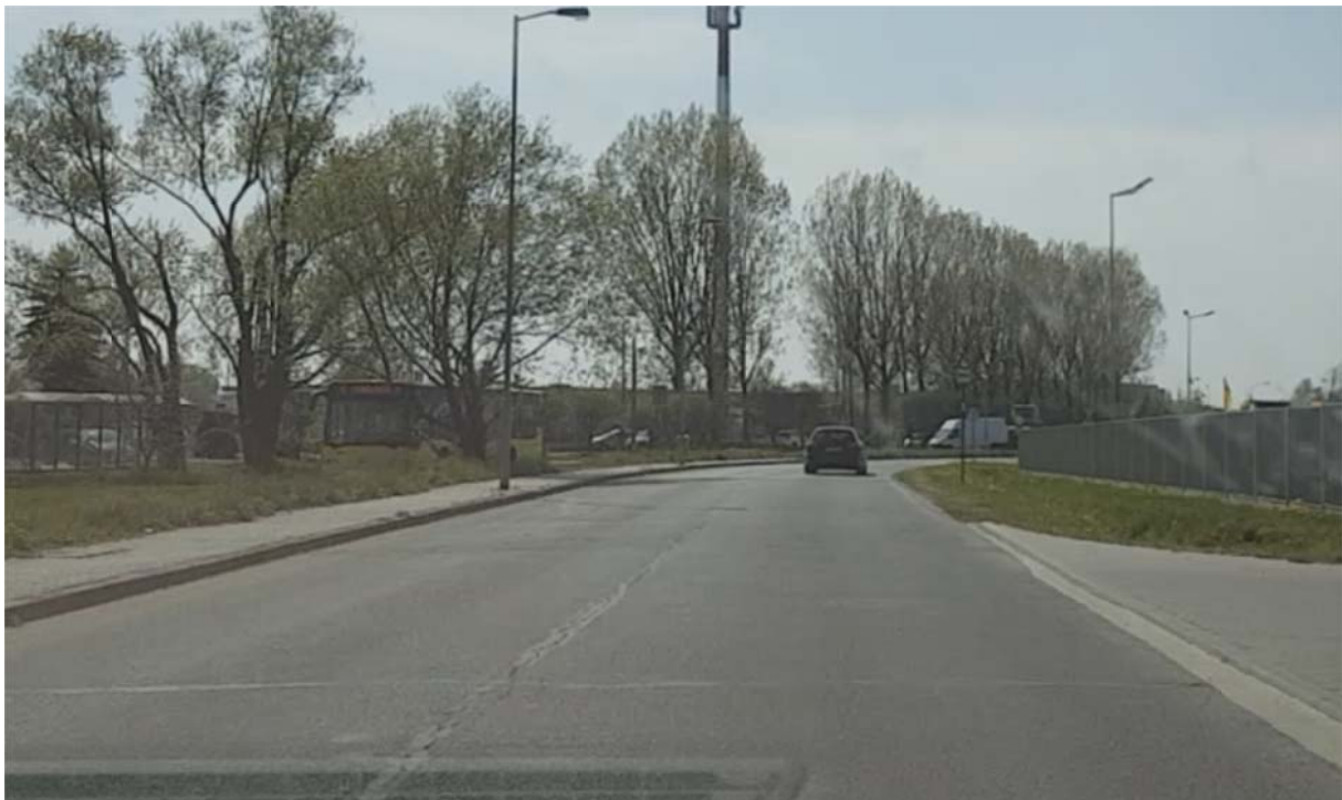
Rys. 4.36 ul. Kolejowa– stan istniejący
