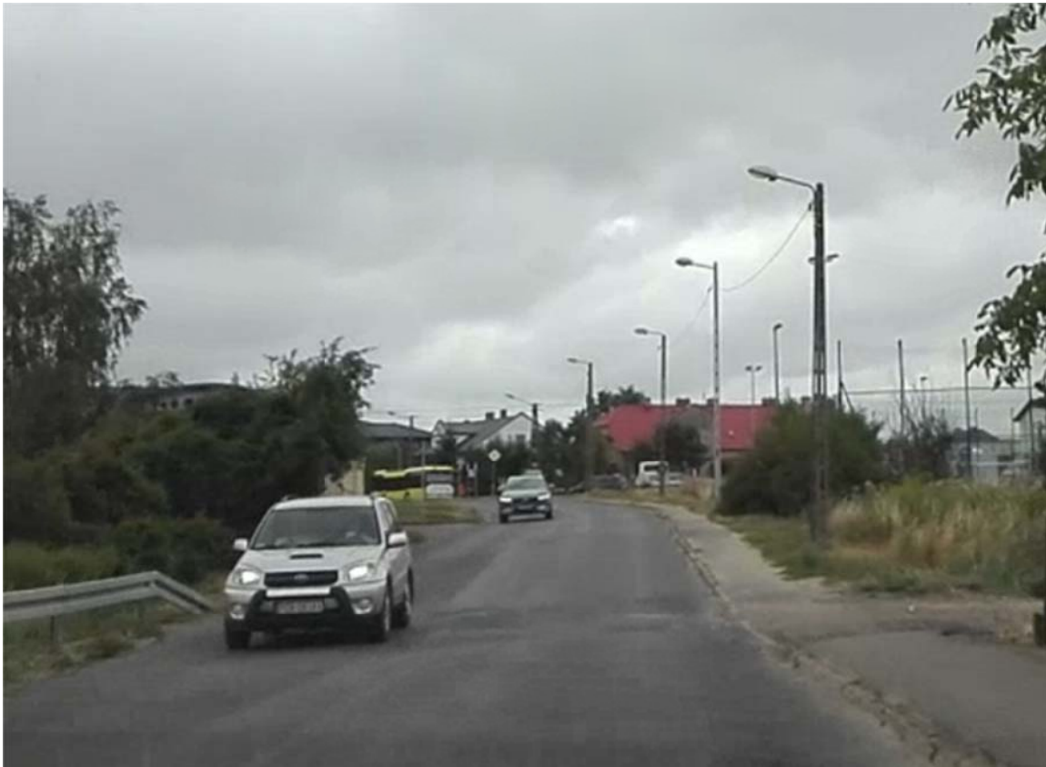
Rys. 4.34 ul. Wierzbiczany– stan istniejący
