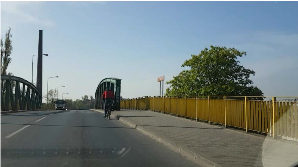
Rys. 4.10 ul. Warszawska – stan istniejący
